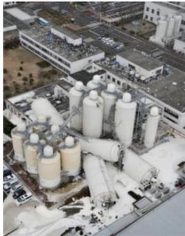
地震で倒壊したビールタンク
