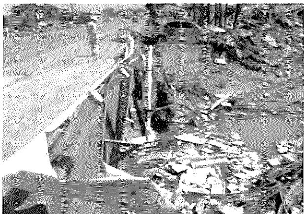
津波で破断し川に落ちた水管橋（亘理町）
