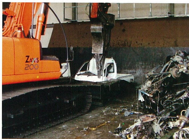
重機による解体作業
